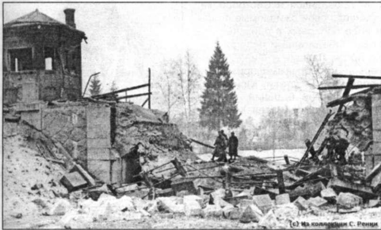
Взорванный железнодорожный мост. Терийоки, 1939 г.
