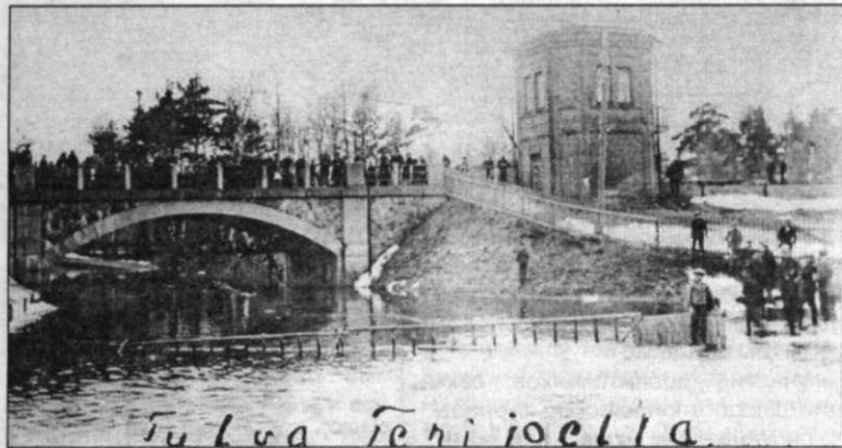
Затопленная дорога под железнодорожным мостом.
