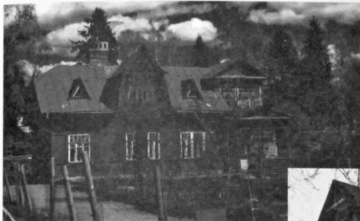
Песочная. Дом начала XX в. на Школьной ул., 28. Фото 2006 г.
