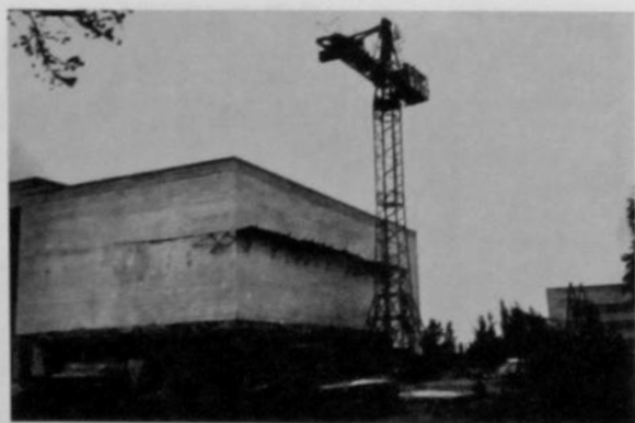
Строительство Радио- логического института. Фото 1960-х гг.
