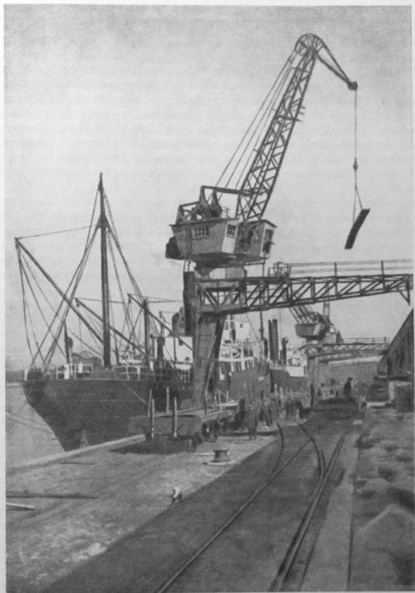
Разгрузка парохода «Енисей» в Ленинградском торговом порту после его реконструкции. 1930-е годы. Фотография.
