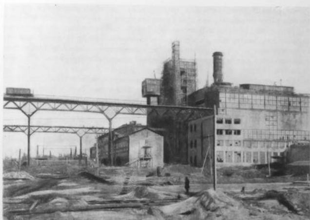
Строительство электростанции Невская Дубровка. Начало 1930-х годов. Фотография.
