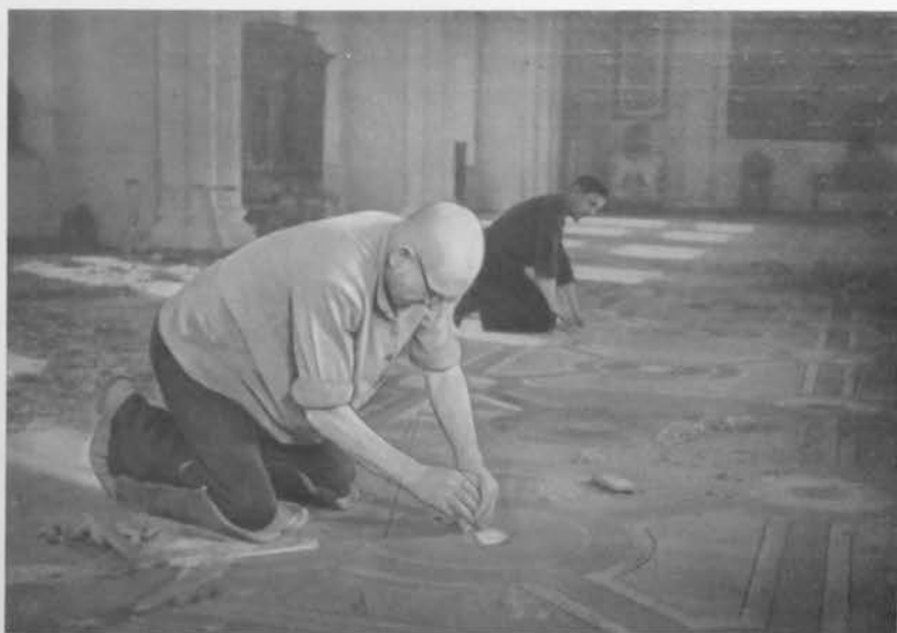
Реставрационные работы в Павловском дворце. Фотография.
