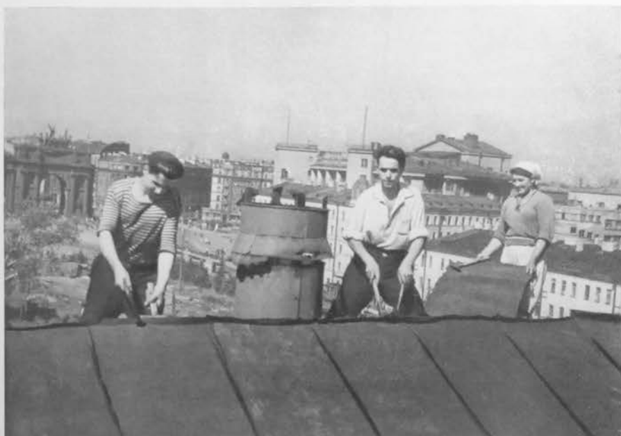
Бригада рабочих Кировского завода ремонтирует здание школы № 384. 1946 г. Фотография.
