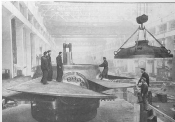
Сборка рабочего колеса турбины для Волжской ГЭС им. В. И. Ленина на Металлическом заводе, 1955 г. Фотография.
