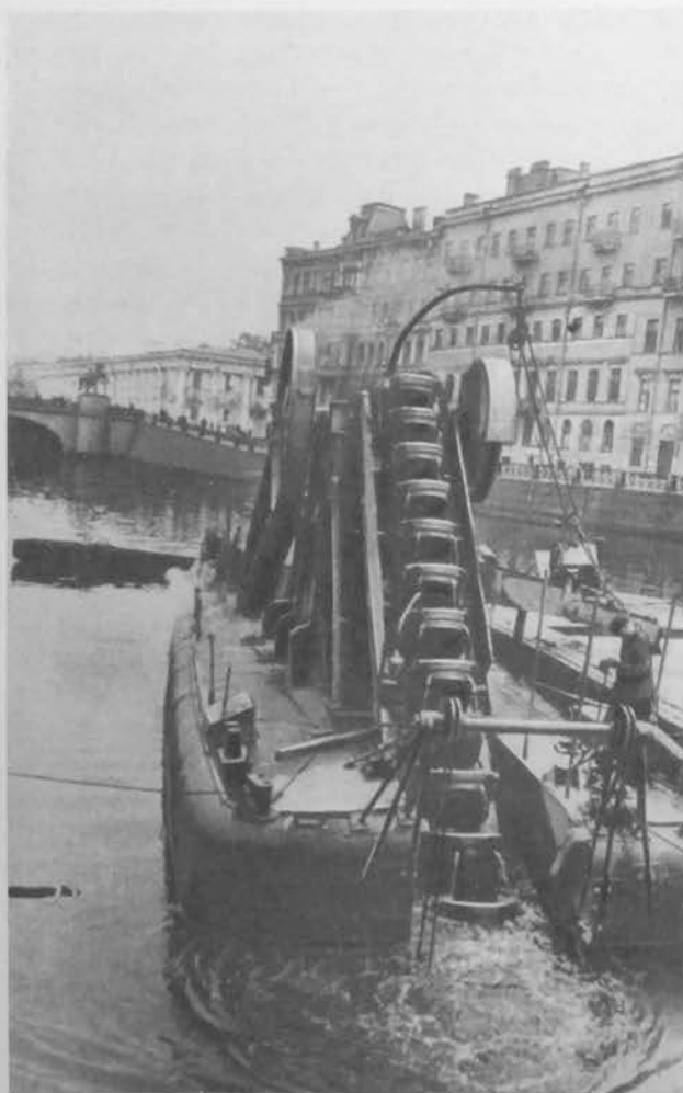
Дноуглубительные работы на реке Фонтанке. 1955 г. Фотография.
