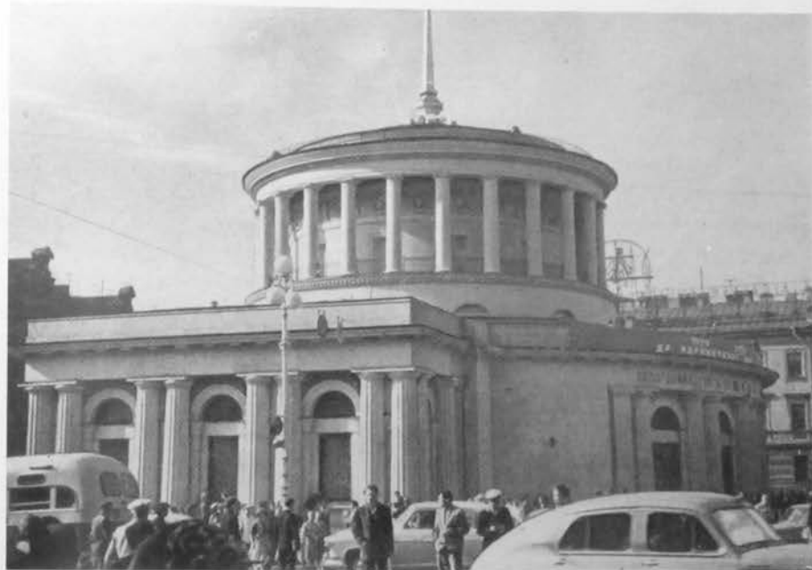
Метрополитен им. В. И. Ленина. Станция «Площадь Восстания». Архитекторы В. В. Ганкевич, Б. Н. Журавлев, И. И. Фомин. 1955 г. Фотография.
