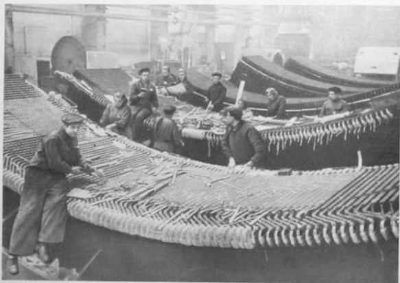
Обмотка статора первого гидрогенератора для Горьковской ГЭС на заводе «Электросила» им. С. М. Кирова. 1952 г. Фотография.
