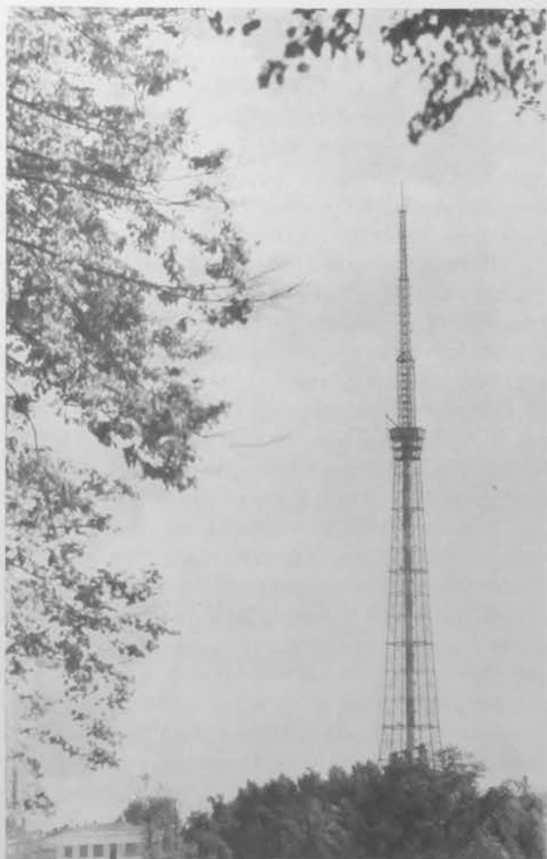
Новая вышка Ленинградского телевизионного центра. 1963 г. Фотография.
