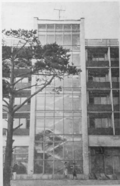
Главный корпус пансионата «Днепр» на Карельском перешейке. 1965 г. Фотография.
