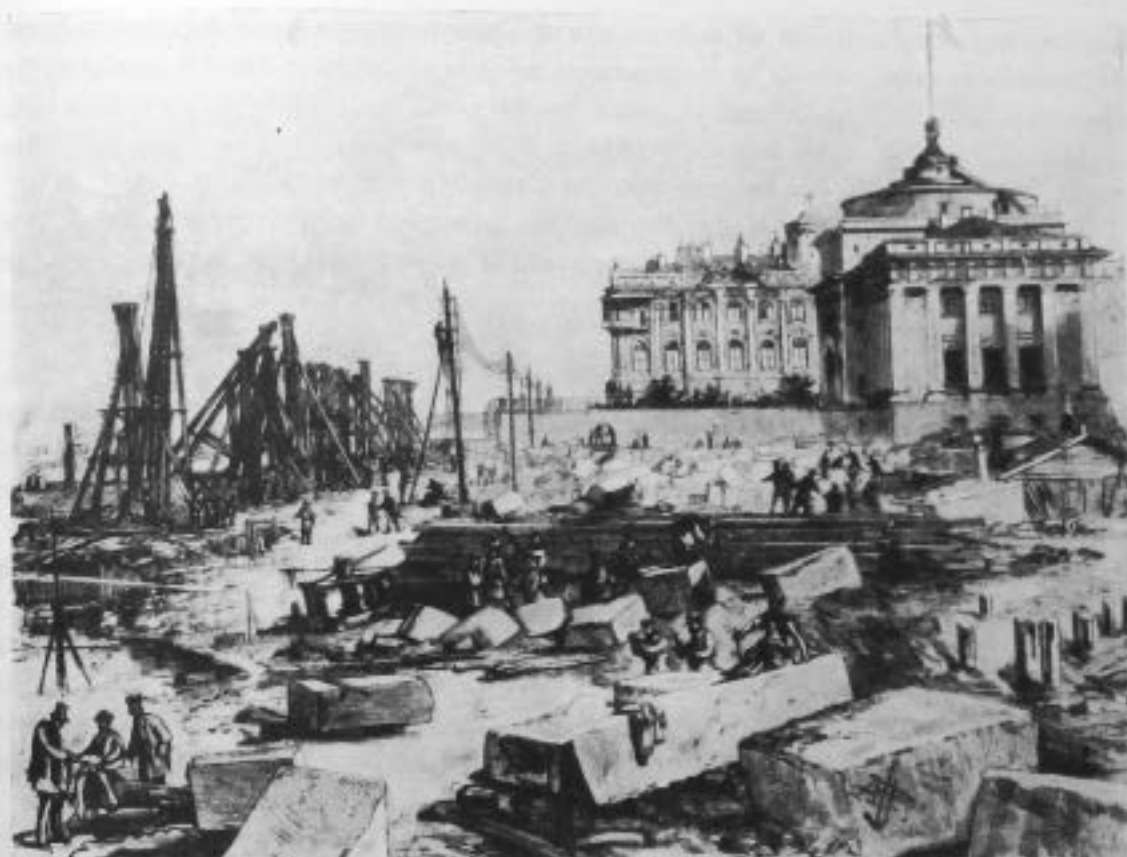
Строительство гранитной набережной у Адмиралтейства. Гравюра. 70-е годы XIX в.
