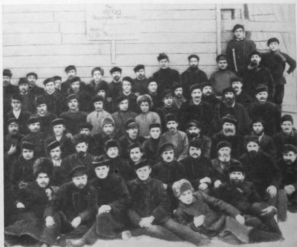
Группа рабочих — участников строительства Пантелеймоновского моста. Фотография начала XX в.
