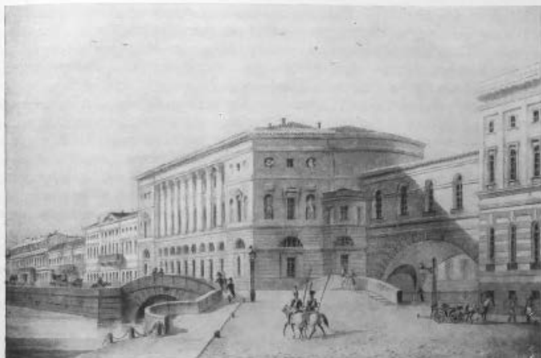
Эрмитажный театр. Построен в 1763—1787 гг. Архитектор Д. Трезини.
