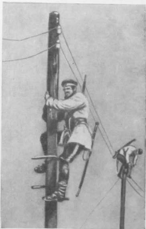
Подвеска телефонных проводов русскими военными телефонистами в 1880-х годах
