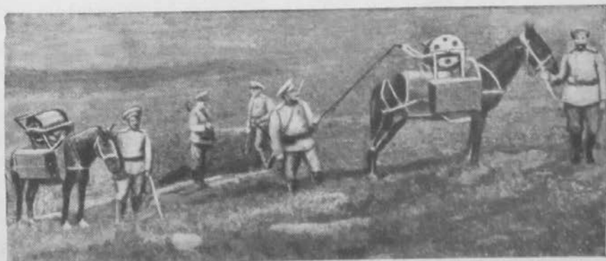
Прокладка русской войсковой частью телефонной линии в горах
