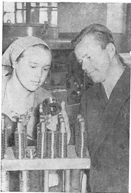
Старший мастер В. А. Гаврилов и резьбошлифовщица В. И. Михайлова проверяют качество резбонакатных плашек.
