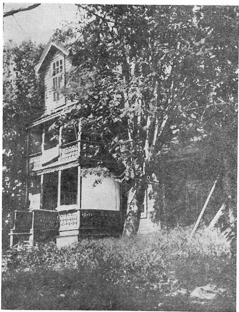
Дача Игнатьевых в Ахи-Ярви. Здесь в 1905—1917 годах находилась революционная подпольная оружейная база.
