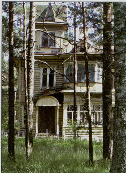
Дача Н.Я. Андреева, разрушенная в 2011 г. Фото Е.М. Травиной. 2010 г.
