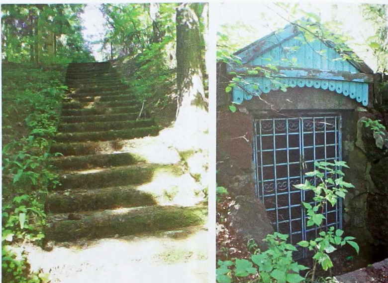
ЛЕСТНИЦА (ПЕР. ОТДЫХА) И ЛЕДНИК (УЧАСТОК ТРЕЙДЕНА)
