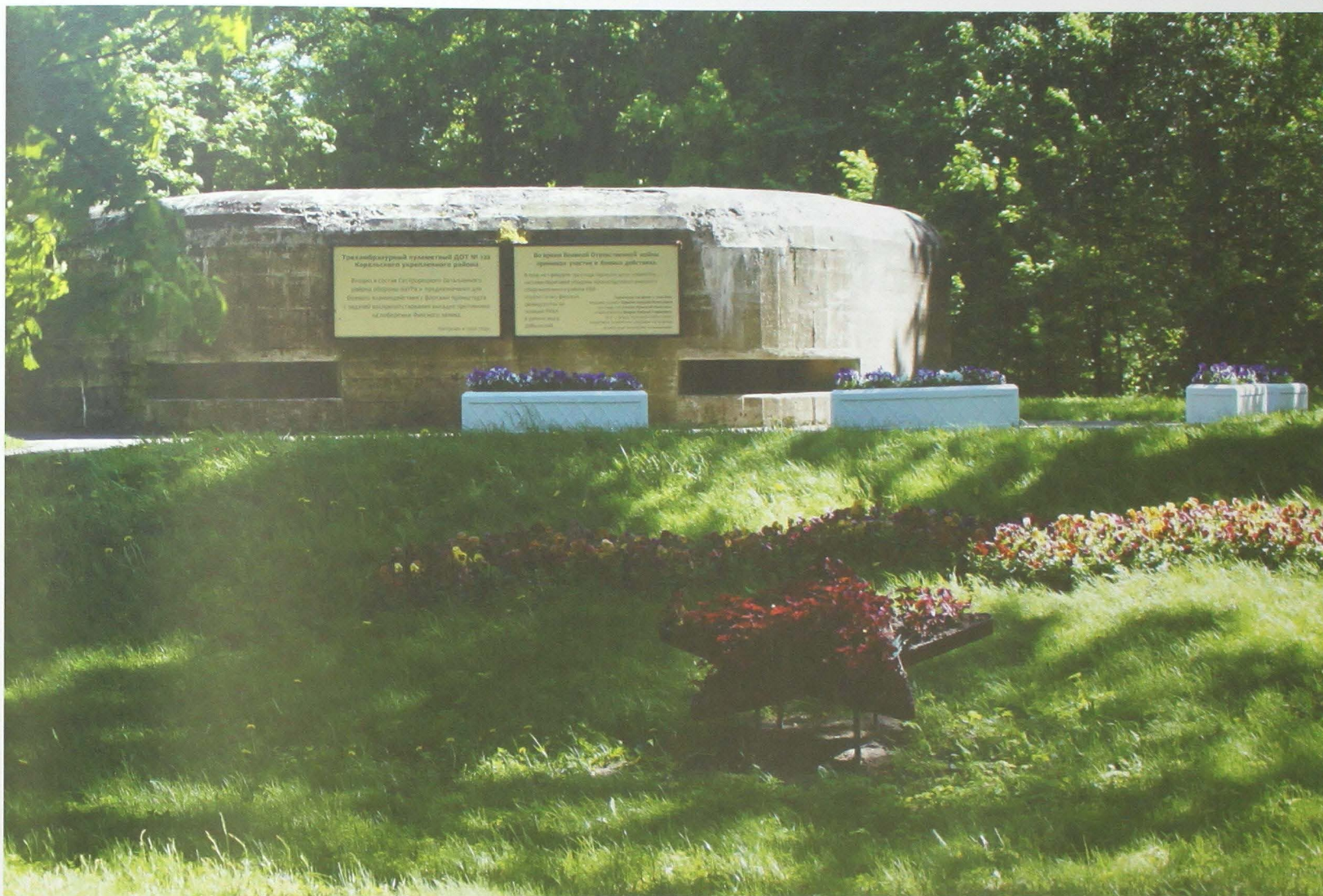
Дубковский мыс. ДОТ № 122 Карельского укрепленного района. Здесь воевали защитники Ленинграда Dubkovsky Cape. DOT number 122 of Karelian fortified area. The defenders of Leningrad were fighting there
