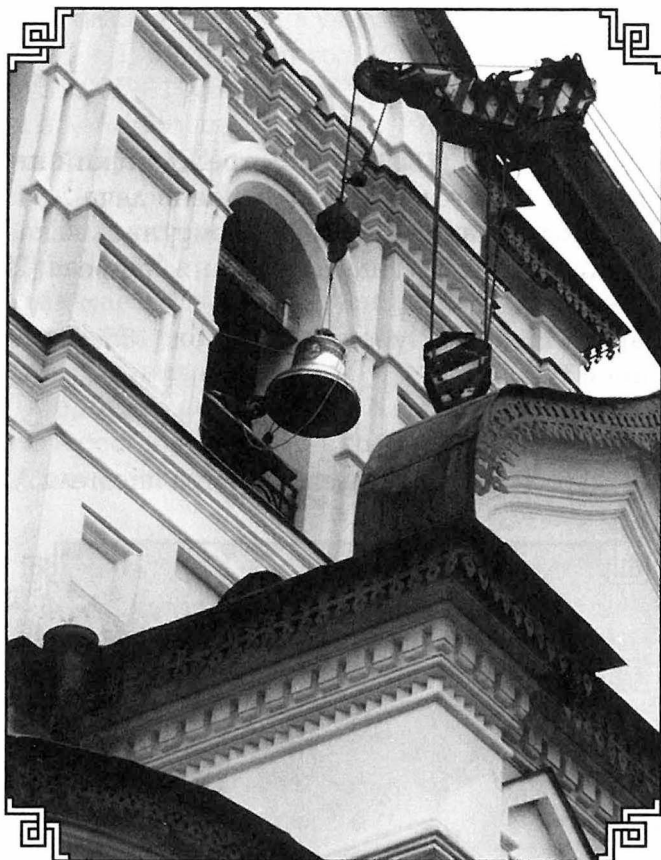
Подъем колокола на колокольню церкви Иконы Казанской Божьей Матери. Начало 1980-х годов (фото с сайта terijoki.spb.ru)
