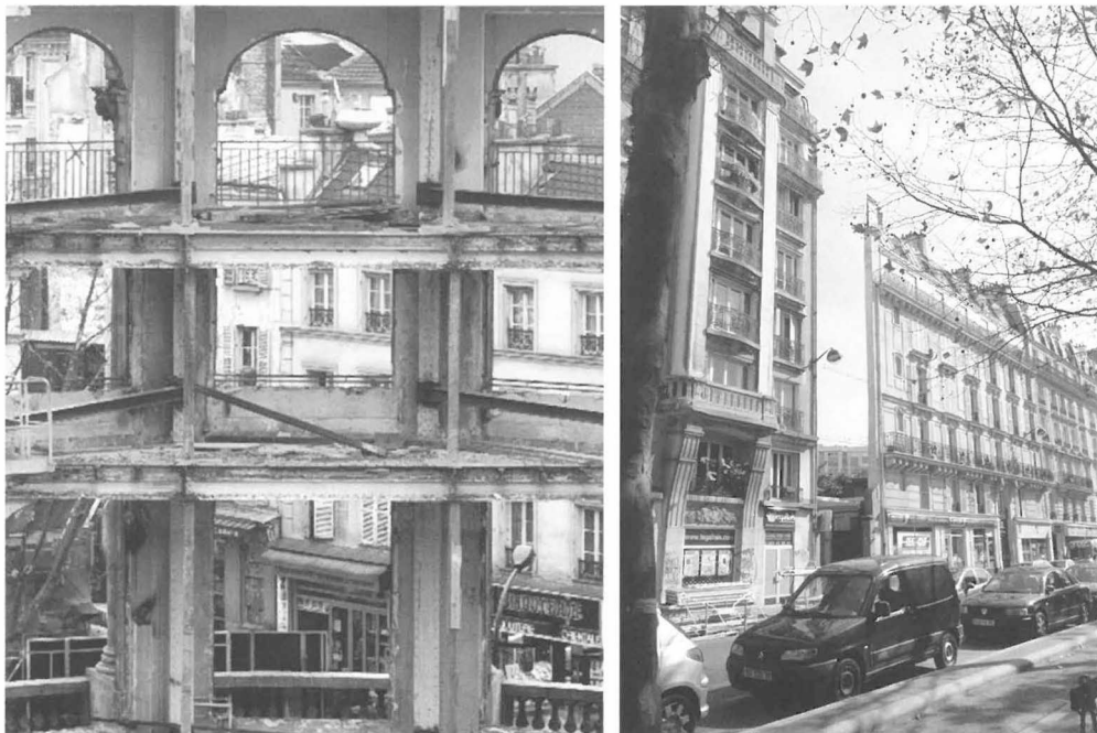
Париж. Реконструкция исторических зданий. http://www.balises.net , http://archdelit.files.wordpress.com
