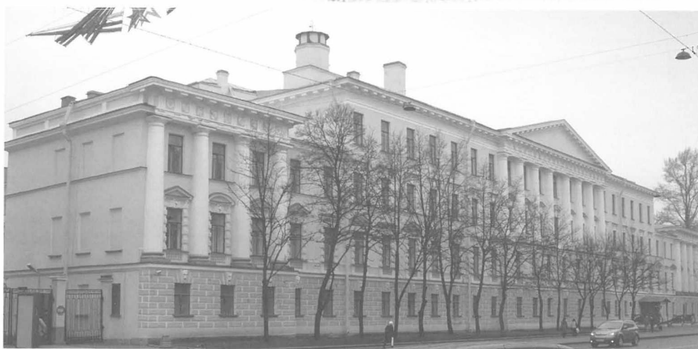
Главный корпус Константиновского училища. 2010 г.
