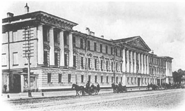
Главный корпус Константиновского училища. 1907 г. http://p2.citywalls.ru
