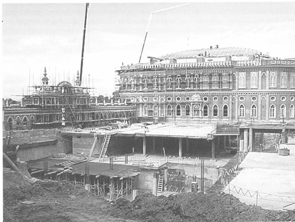
Строительство подземного вестибюля. 2006 г. http://mw2.google.com
