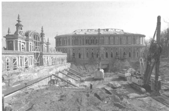
Подготовка котлована для подземного вестибюля. 2005 г. http://nikitapaout.ru
