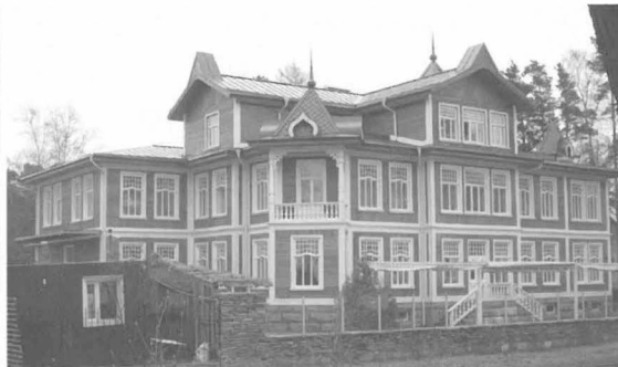
«Дача Ф. В. Шаповаленко». После реконструкции
