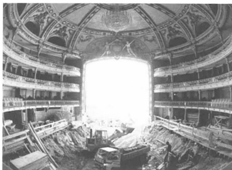
Брага. Teatro Circo. Работы по расширению подземного пространства. http://i245.photobucket.com
