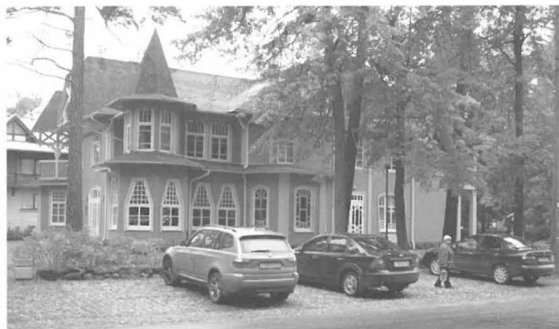
«Дача О. Р. Кондратьевой». После реконструкции
