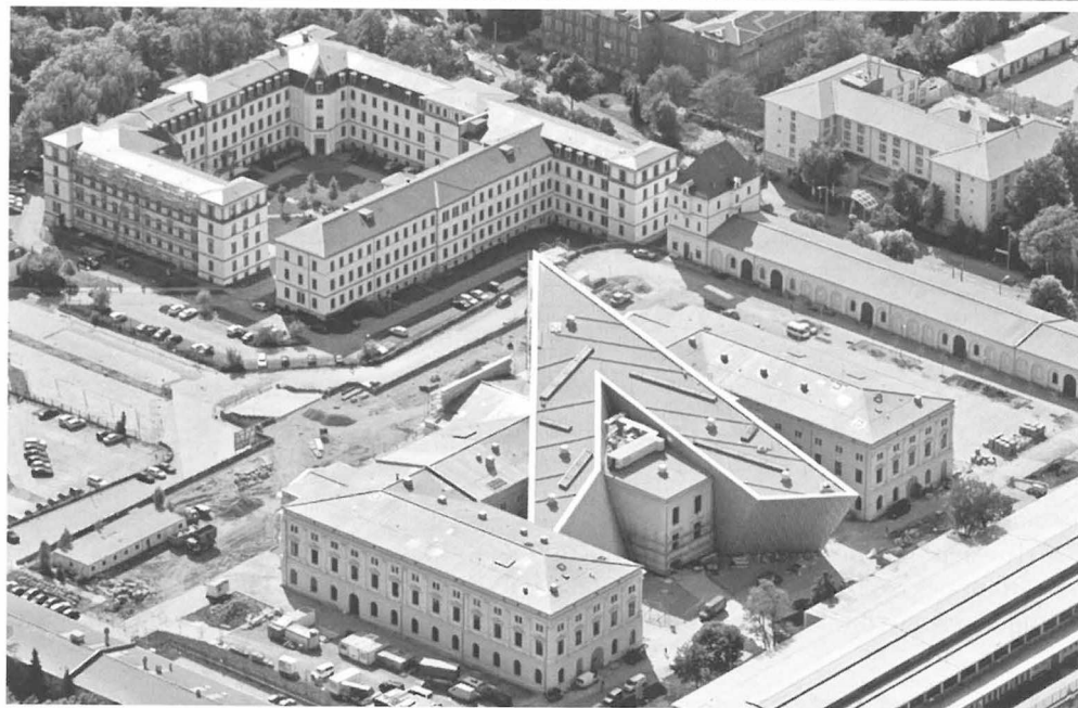
Дрезден. Военно-исторического музея вооруженных сил Германии. http://ad009cdnb.archdaily.net
