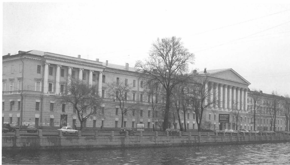
Главный корпус Обуховской больницы. 2007 г.
