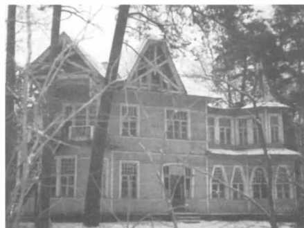
«Дача О. Р. Кондратьевой». До реконструкции
