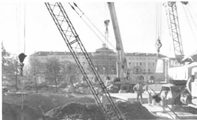
Строительные работы в Нижнем саду. http://www.stpr.ru
