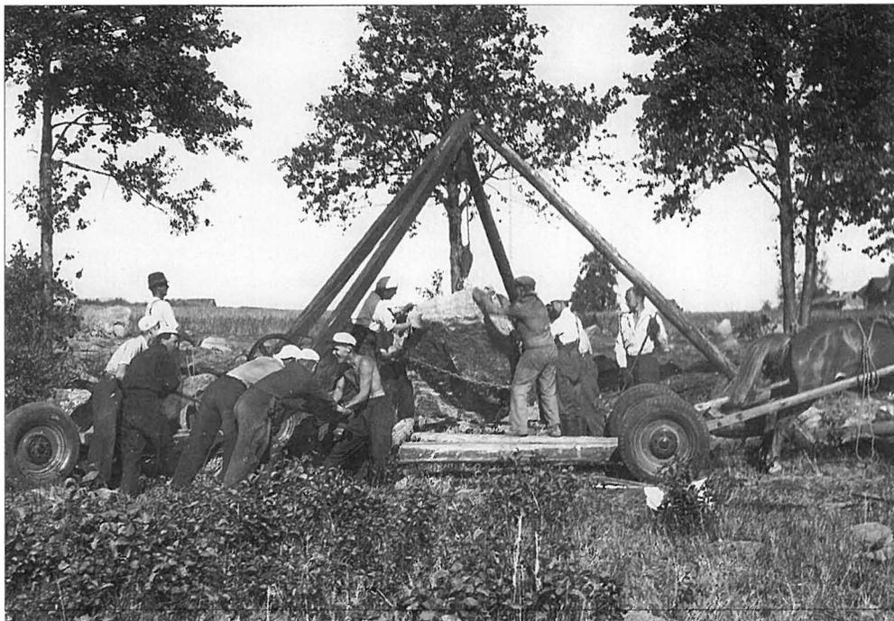
*С помощью таких приспособлений финны транспортировали гранитные глыбы.
