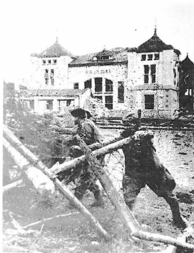
Снос проволочных заграждений у вокзала Раяйоки в июне 1944г.
