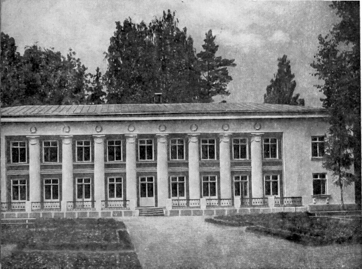
Здание детского сада Куйбышевского района в Ушкове (архитектор В. Д. Кирхоглани)
