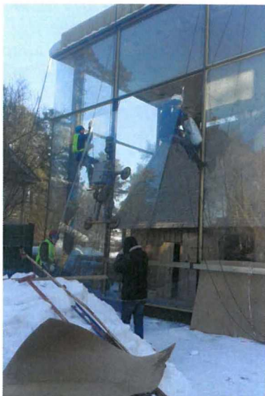
Замена стекла защитного сооружения музея «Сарай Н. А. Емельянова», 2015 г.
