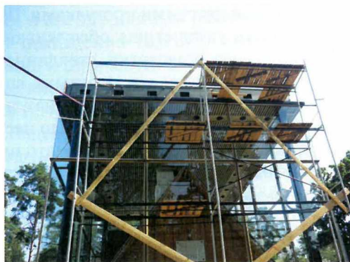
Устройство вентиляции кровли музея «Сарай Н. А. Емельянова», 2010 г.
