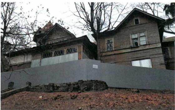
«Дача И. С. Крючкова» (пос. Репино, Приморское ш., 394, корп. 6) После выполнения консервационных работ. Фрагмент 1
