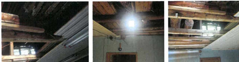
Необычная конструкция – тройной (!) потолок. Зачем?
