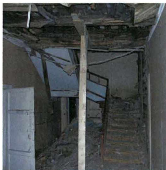
«Дача Е. Ф. Важевской» (г. Сестрорецк, Андреева ул., д. 12, лит. А). Фрагмент состояния внутренних помещений до проведения консервации
