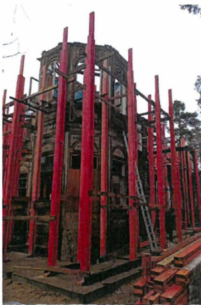
«Дача Н. М. Кочкина» (г. Сестрорецк, М. Горького ул., д. 8, лит. А). В процессе производства работ по консервации. Фрагмент 2
