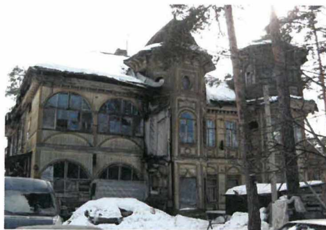
«Дача Н. М. Кочкина» (г. Сестрорецк, М. Горького ул., д. 8, лит. А). Состояние до мая 2018 года
