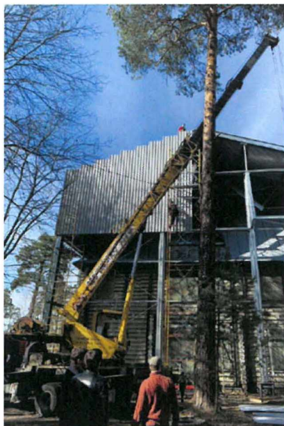
«Дача Е. Ф. Важевской» (г. Сестрорецк, Андреева ул., д. 12, лит. А). В процессе выполнения работ по консервации. Фрагмент 5
