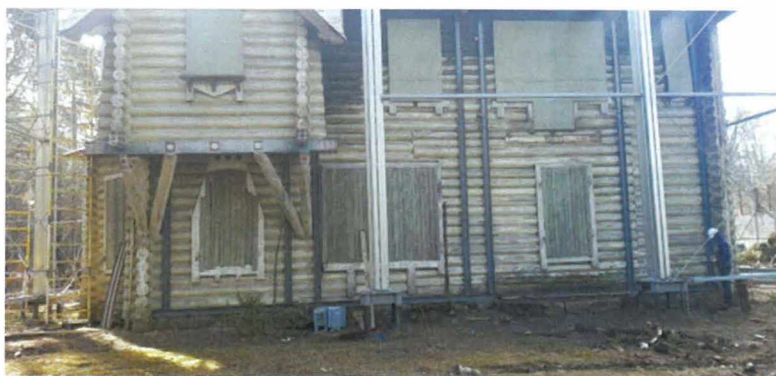
«Дача Е.Ф. Важевской» (г. Сестрорецк, Андреева ул., д. 12, лит. А). В процессе выполнения работ по консервации. Фрагмент 3
