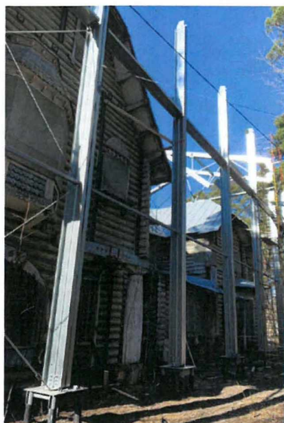
«Дача Е. Ф. Важевской» (г. Сестрорецк, Андреева ул., д. 12, лит. А). В процессе выполнения работ по консервации. Фрагмент 2
