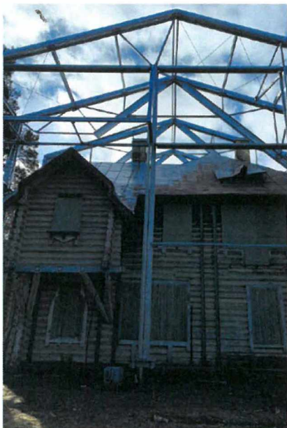
«Дача Е. Ф. Важевской» (г. Сестрорецк, Андреева ул., д. 12, лит. А). В процессе выполнения работ по консервации. Фрагмент 4
