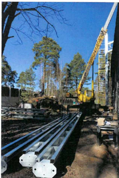
«Дача Е. Ф. Важевской» (г. Сестрорецк, Андреева ул., д. 12, лит. А). В процессе выполнения работ по консервации. Фрагмент 1
