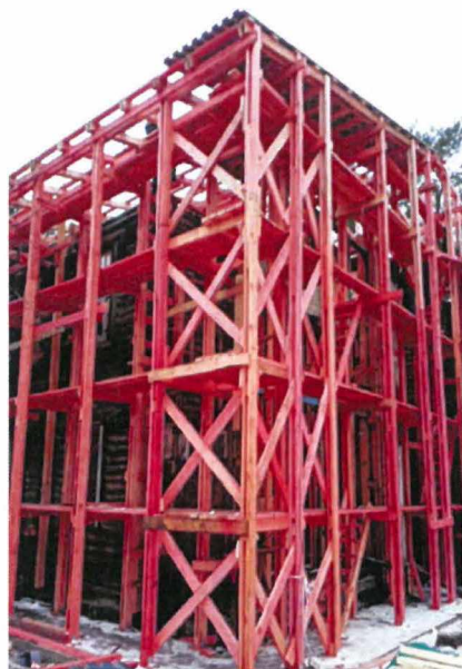
«Дача Н. М. Кочкина» (г. Сестрорецк, М. Горького ул., д. 8, лит. А). В процессе производства работ по консервации. Фрагмент 3
