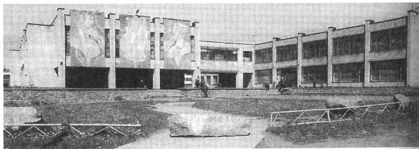
Илл. 61. Здание местного Дома культуры.
