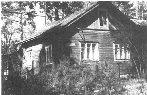
Рис. 4. Выборгское шоссе д.26. 1944-1949г.г. - в этом доме была городская телефонная станция
