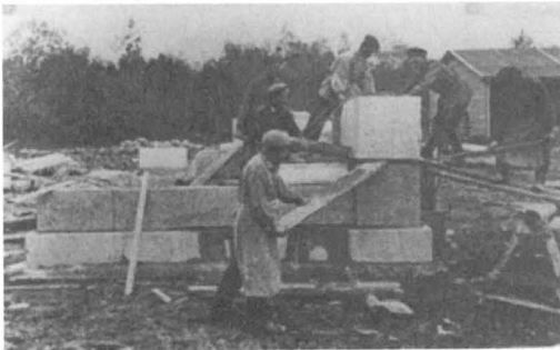
Строительство памятника. Монтаж гранитных блоков. Фото из коллекции Б.Е. Ривкина.
