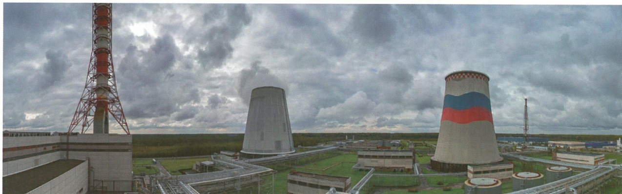
Северо-Западная ТЭЦ в Санкт-Петербурге, построенная под руководством Лохматикова Г.П.
