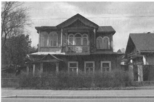
Илл. 9 Ул. Коммунаров, дом № 53 (до реконструкции)
