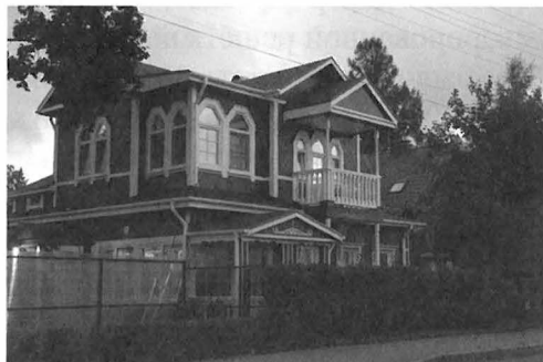
Илл. 10 Ул. Коммунаров, дом № 53 (после реконструкции)
