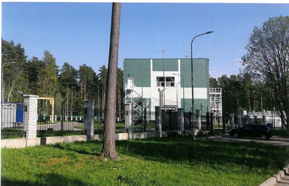
Канализационные очистные сооружения
