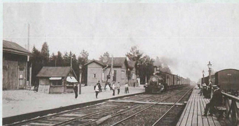
Железнодорожная станция Дибуны Фото начала XX века
