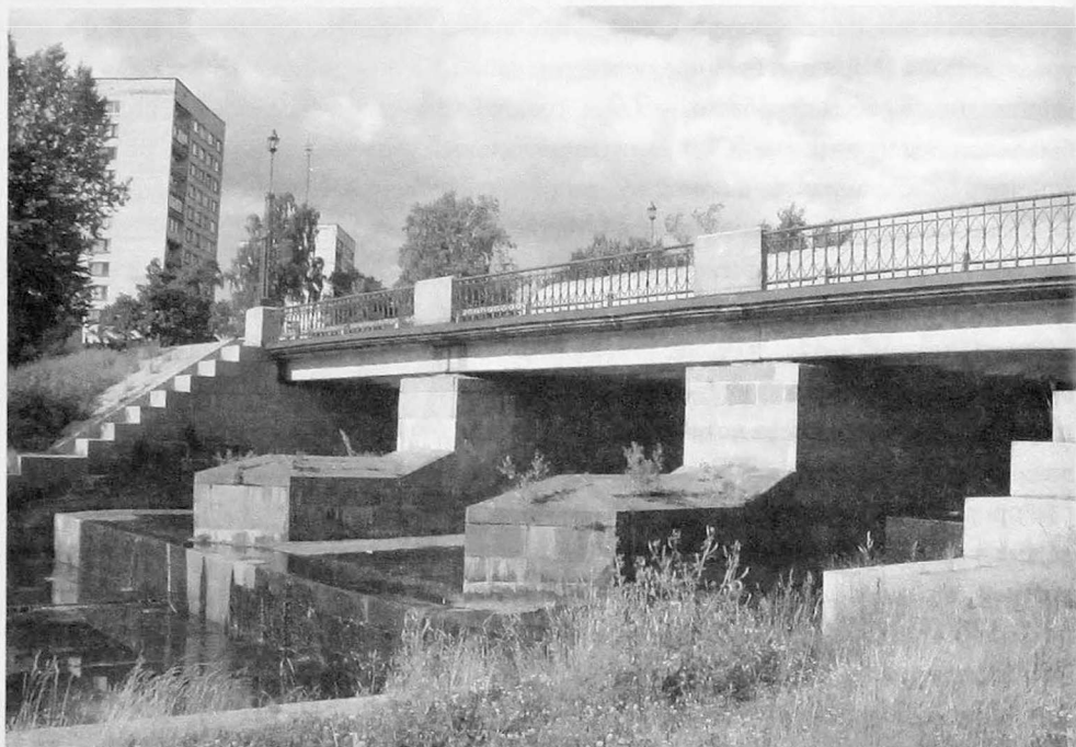
Общий вид плотины Гаусмана. 2005 г.
