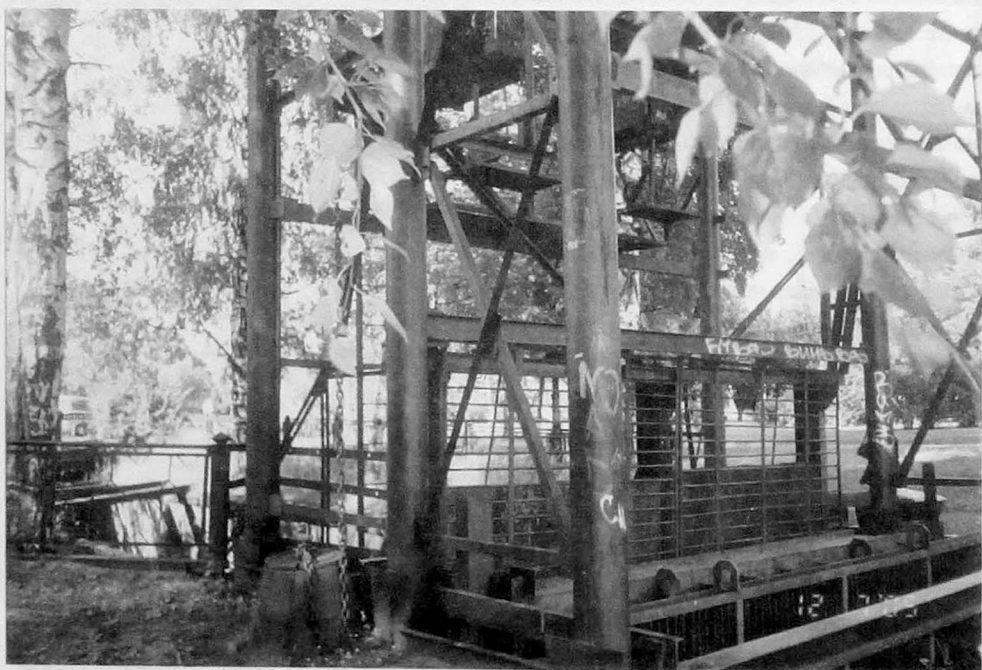
Общий вид заводской плотины. 2005 г.
