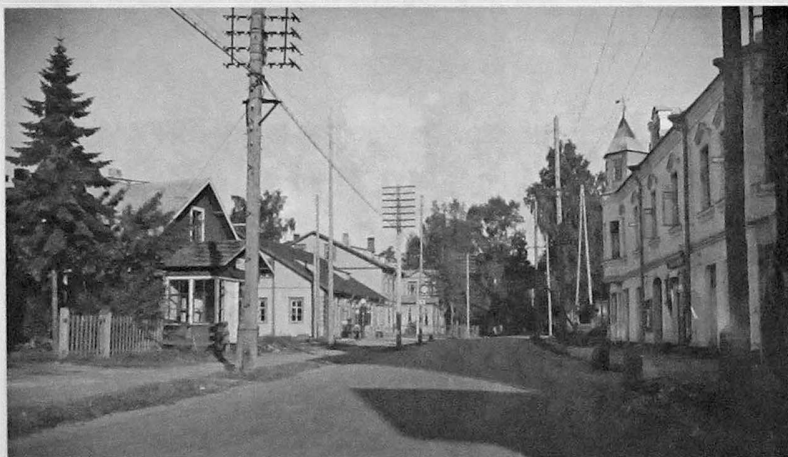
Справа — здание на Нижней Виертотие (ныне Приморское ш.), в первом этаже которого размещался магазин А. В. Пошехонова
