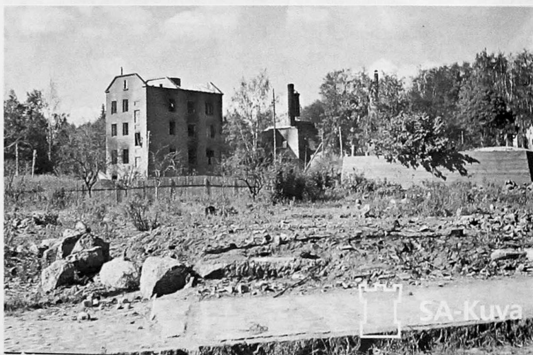
Обгоревший корпус пивоваренного завода. Терийоки, 2 сентября 1941 г.
