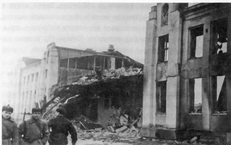
Вокзал Терийоки с разрушенной центральной частью, 1939 г.
