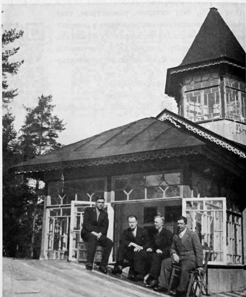
Советские переселенцы на крыше дома первого коменданта Терийоки М. Карченко, бывшей дачи курорта Суоми-Ривьера. Фотография 1940 г.
